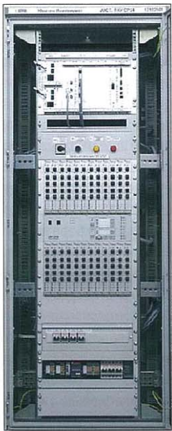
Аппаратура АКСТ РЗПА «Линия-Ц» с возможностью передачи команд РЗ и ПА с ПКУ СР-24
