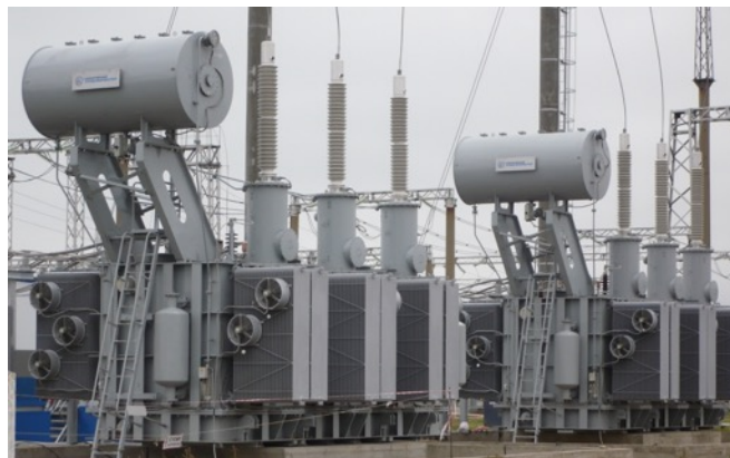
Управляемый шунтирующий реактор УШРТ-50000/220 на П/С 220 кВ "Светлая"
