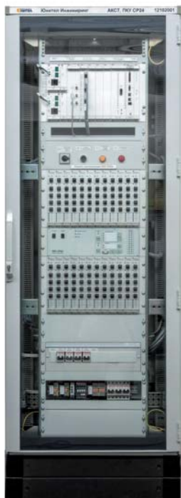
Шкаф ПКУ СР24 с ВЧ аппаратурой АКСТ «Линия-Ц»
